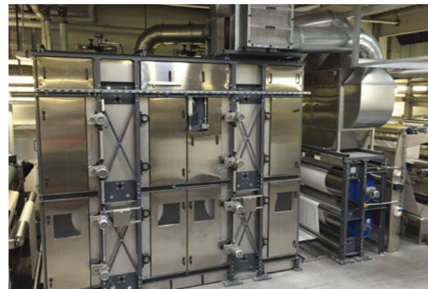
Wärmerückgewinnungsanlage
